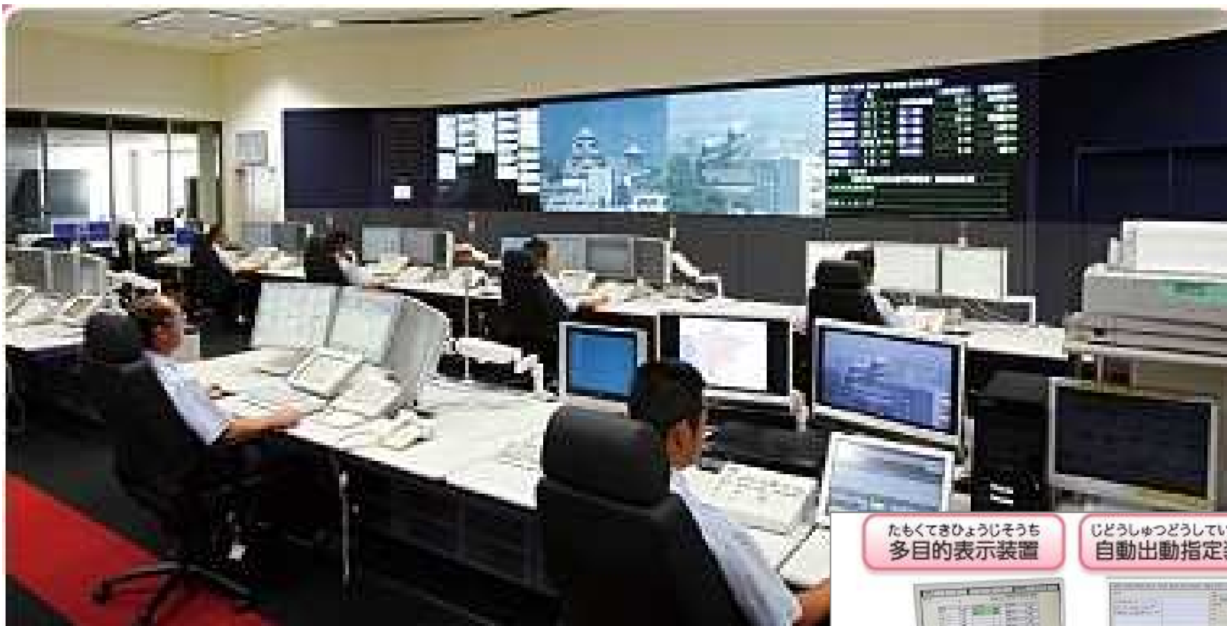
消防指令室 (全景)
