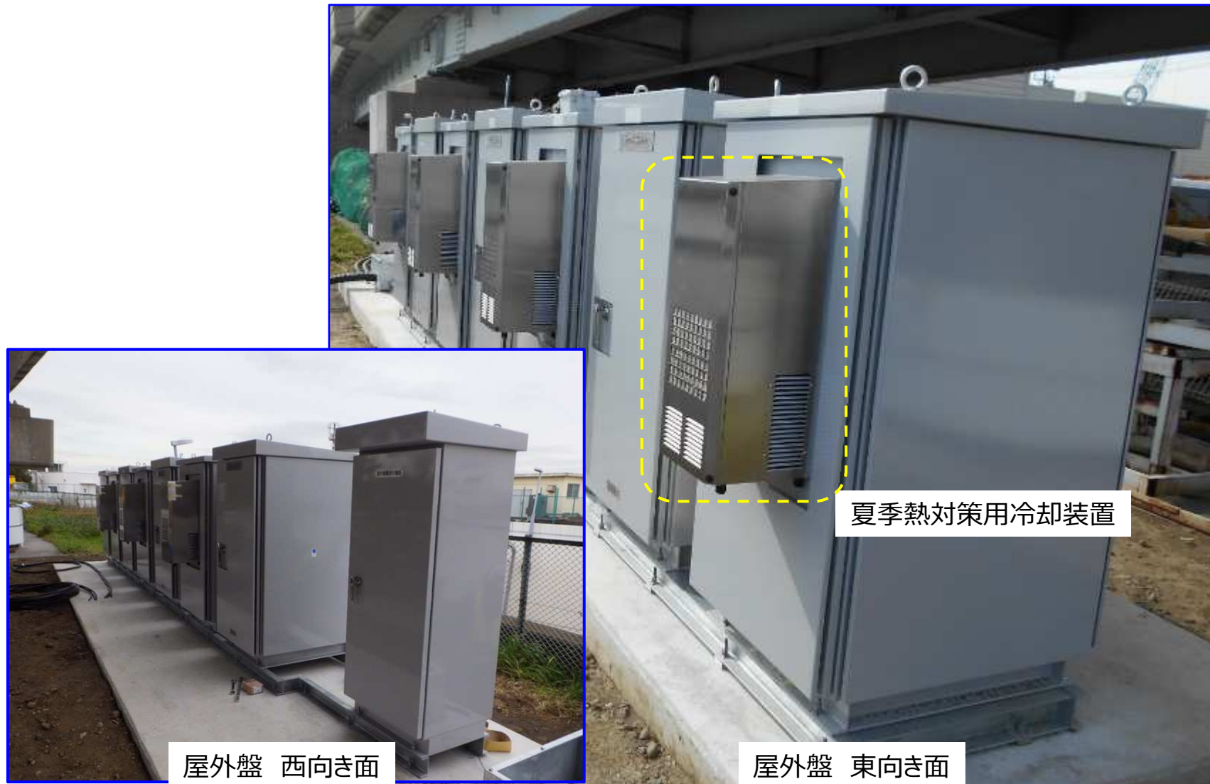
図3-6 ETCゲート通過支援情報提供管理サーバ及び、センサメーカー各社の路側処理装置を格納した屋外盤外観
