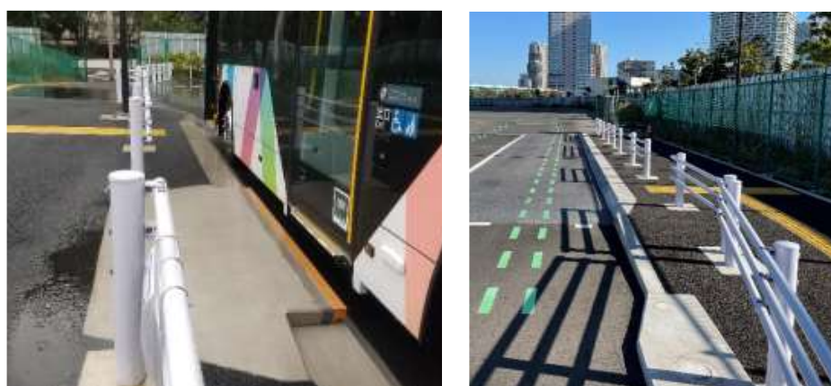
図 2 晴海 BRT ターミナルのバスバース（左：メインバース、右：サブバース）
