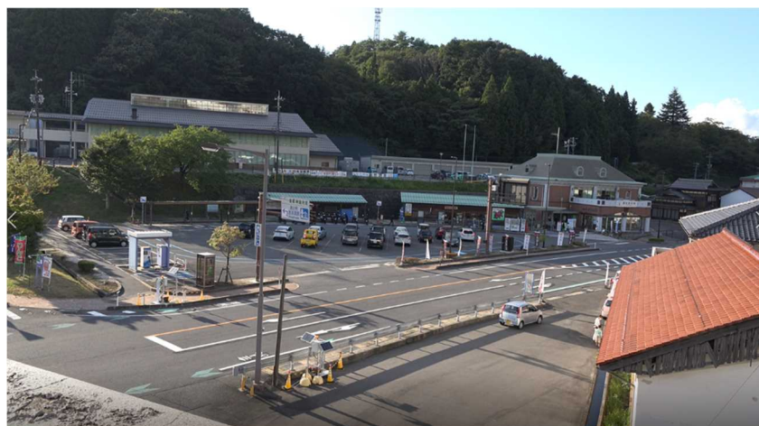
図 1-13 駐車場付近の映像データの例
