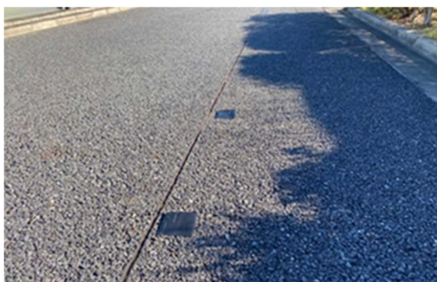
図 1-48 RFID 配置の様子
