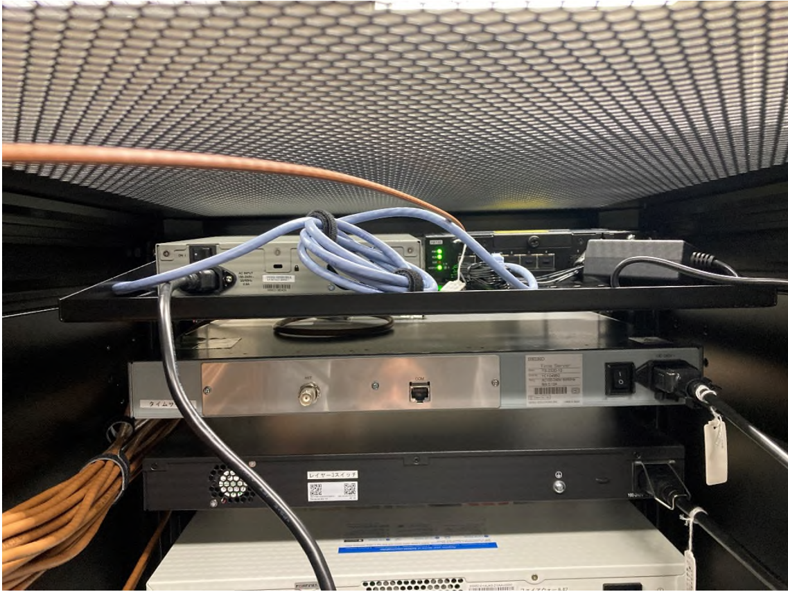
図 7. 3 警察庁に設置後の ONU とルーター（ラック最上段のトレイ上に設置）
