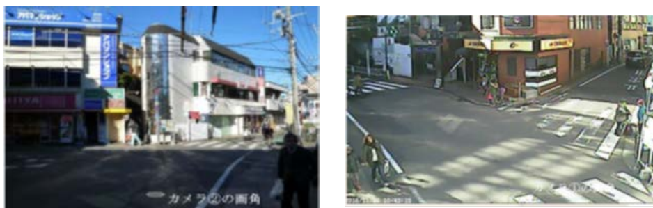
図 6-25 菊名駅西口周辺の定点観測箇所の状況
