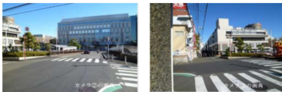
図 6-29 日吉駅周辺の陸橋端の無信号交差点の定点観測箇所状況
