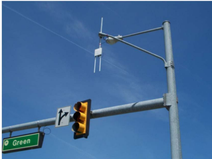
図 1.1-2 信号に取り付けられた RSU
