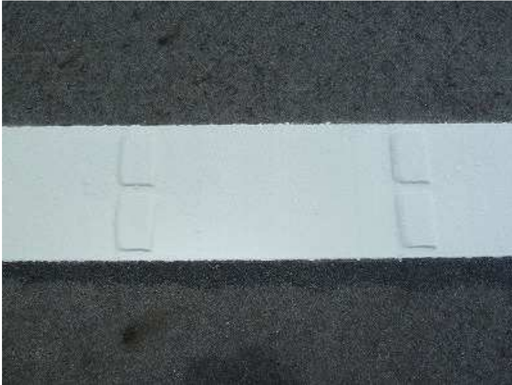
図 1.3.1-4 リブ式高輝度白線標示拡大写真
