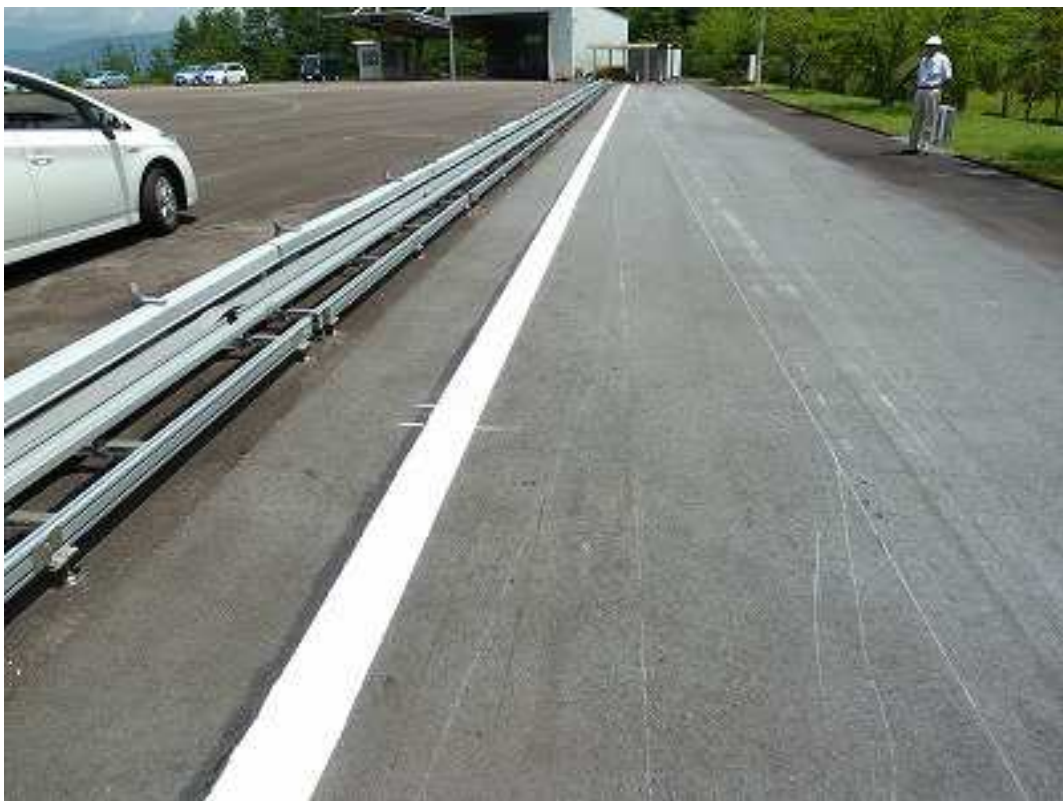
図 1.3.1-3 リブ式高輝度白線標示設置後状況
