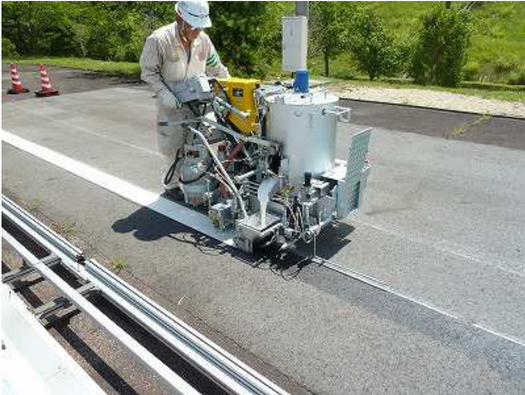
図 1.3.1-2 リブ式高輝度白線標示設置状況
