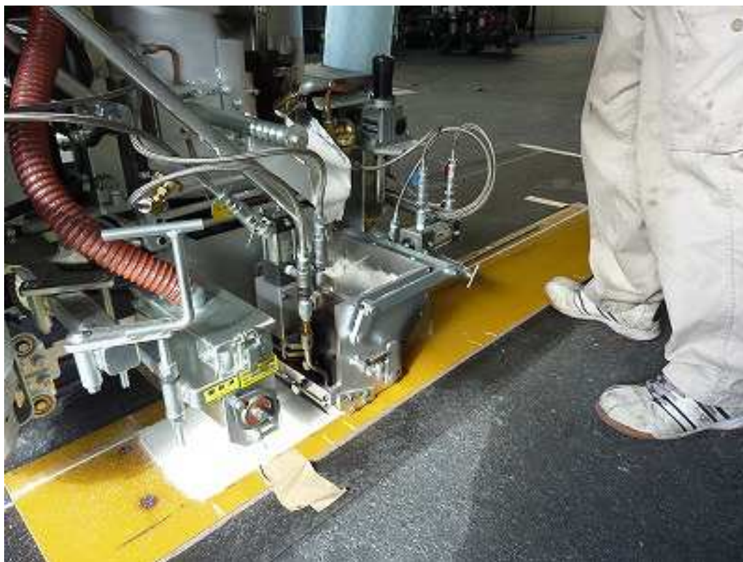
図 1.2.1-3 リブ高さ検証時の施工状況
