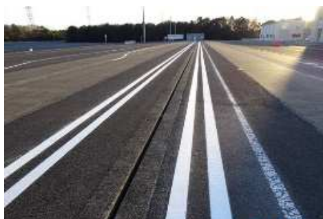
図 5.1.3-7 旧衝突実験場に製作した白線摩耗試験路
