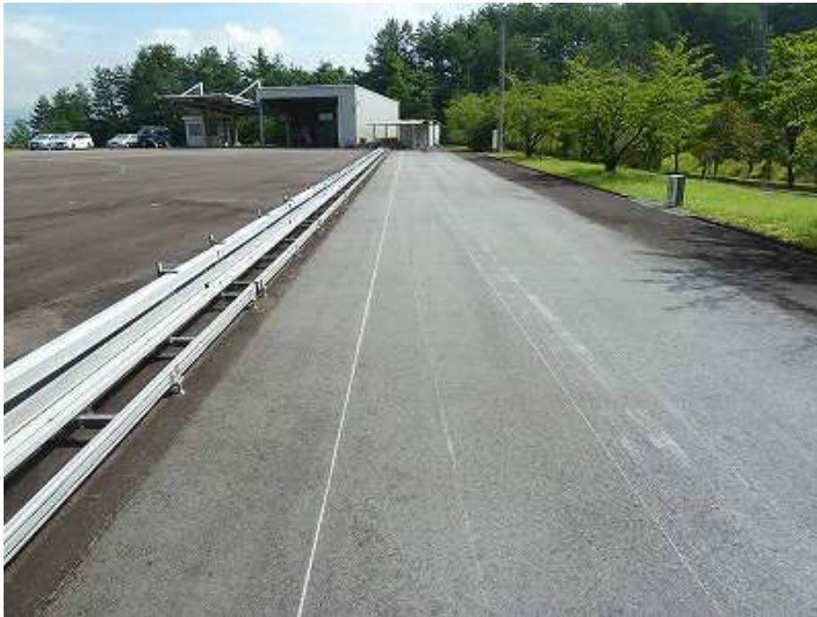
図 1.3.1-1 リブ式高輝度白線標示設置テストコース 設置前
