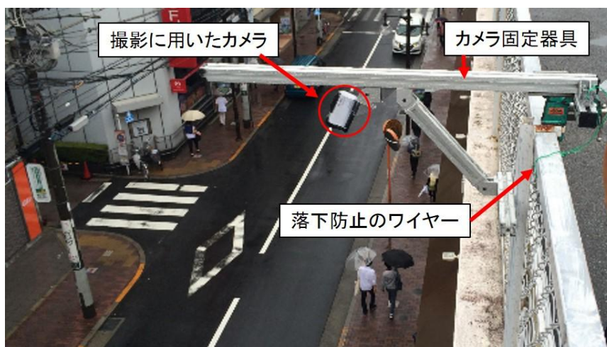
図 4.3.4-2 設置したカメラの様子
