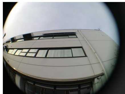
図 6-38 試験場所 (屋外測定点から上方を撮影)
