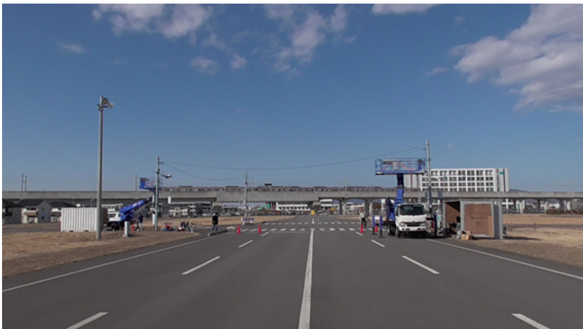
図 5.1.3-2 交差点に 79GHz レーダーを 2 か所に設置した時の状況
