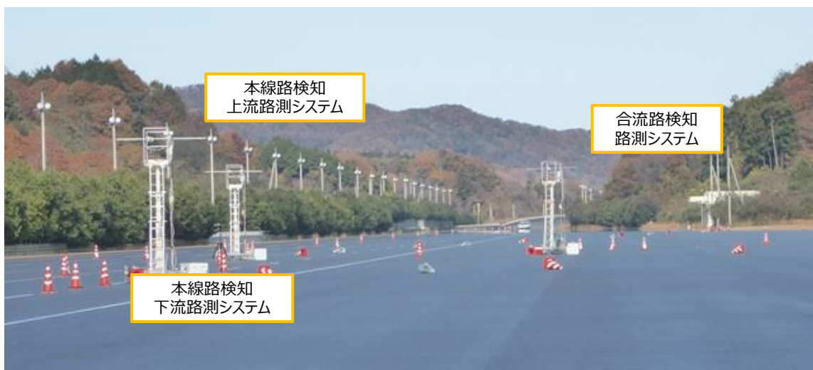
図 5.4.2-18 路側システム配置景観
