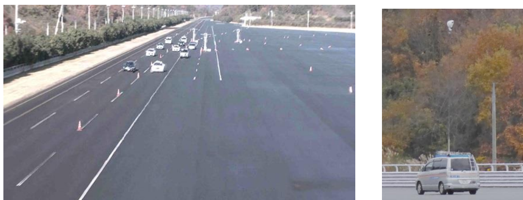
図 5.4.2-22 撮影アングルと機材設置状況：撮影 1（高所）
