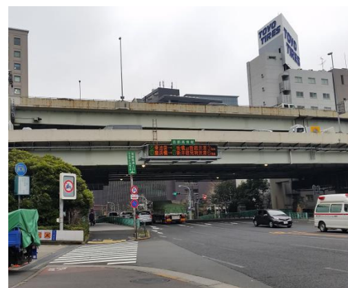
(b) 北側(地点 B 側)からの高架橋風景
