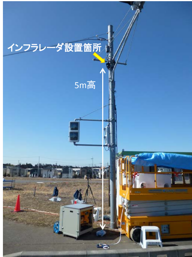
図 5.1.3.1.2-1 インフラレーダーの設置状況
