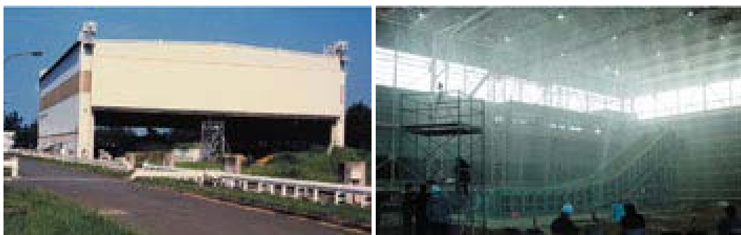
図 5.3.2.1.2-1 大型降雨実験施設[2]
