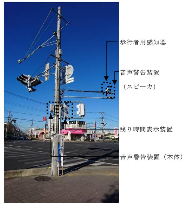
図 3-8 機器設置写真 (C柱、D柱)
