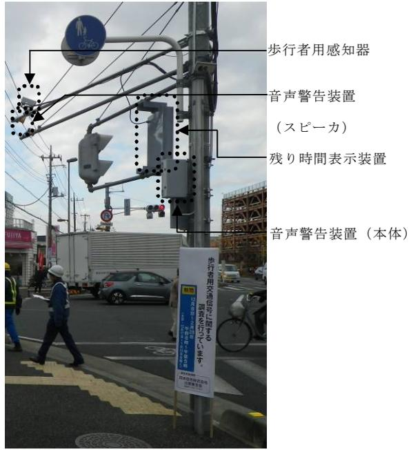
図 3-9 機器設置写真 (E柱)
