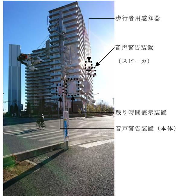
図 3-7 機器設置写真 (A柱、B柱)
